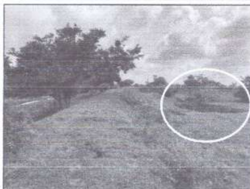
Foto N°22 y 23. Paralelo al terraplen antiguo, se evidencian las excavaciones realizadas para la conformación del terraplen. Coordenada 13
