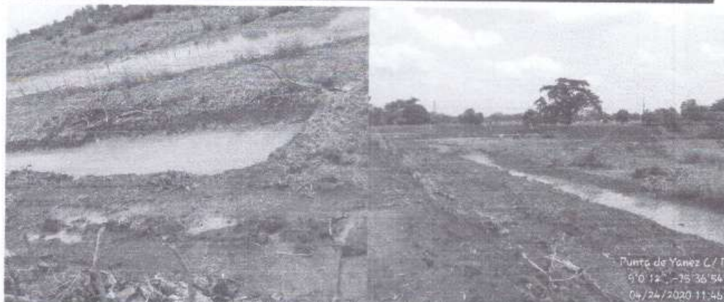
Fotos N° 14 y 15. Zanjas intermitentes a los lados del terraplén.
