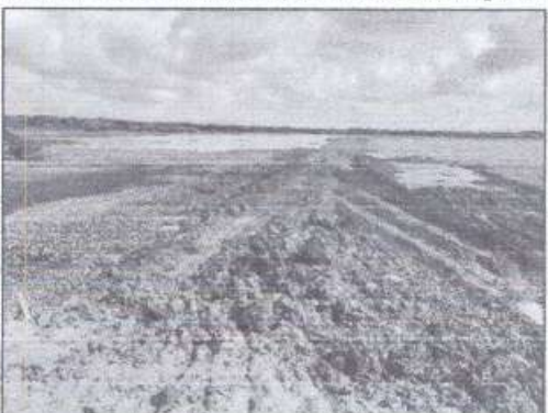
Foto N°15 y 16. Nuevo terraplen, se evidencia conformación y realce del mismo. Coordenada 9.
