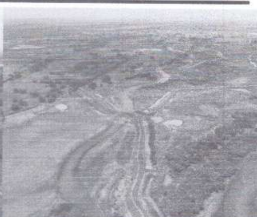
Foto N° 7. Se observa movimientos de terreno para la consolidación del terraplén
