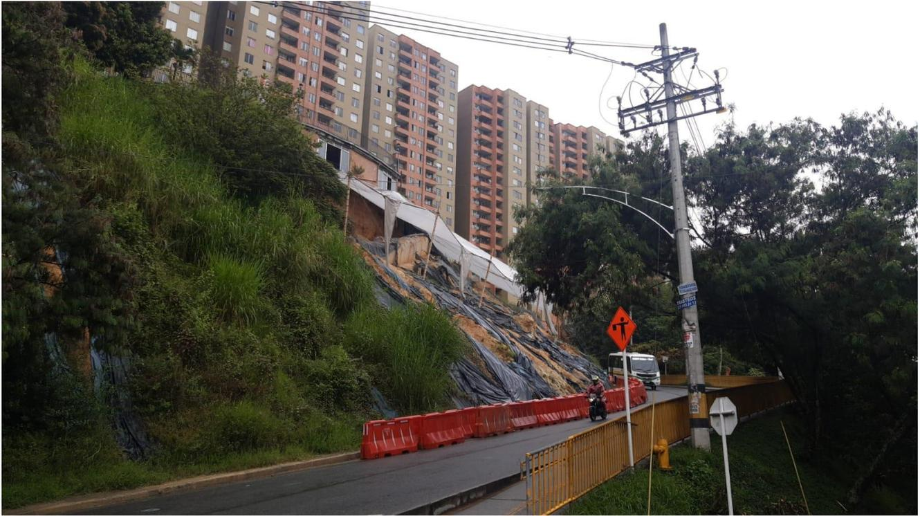
FOTOGRAFIA A JUNIO DE 2023 – MURO DE CONTENCION PROVOCANDO PELIGRO DE VENIRSE HACIA ABAJO AL IGUAL QUE LA CONSTRUCCION
