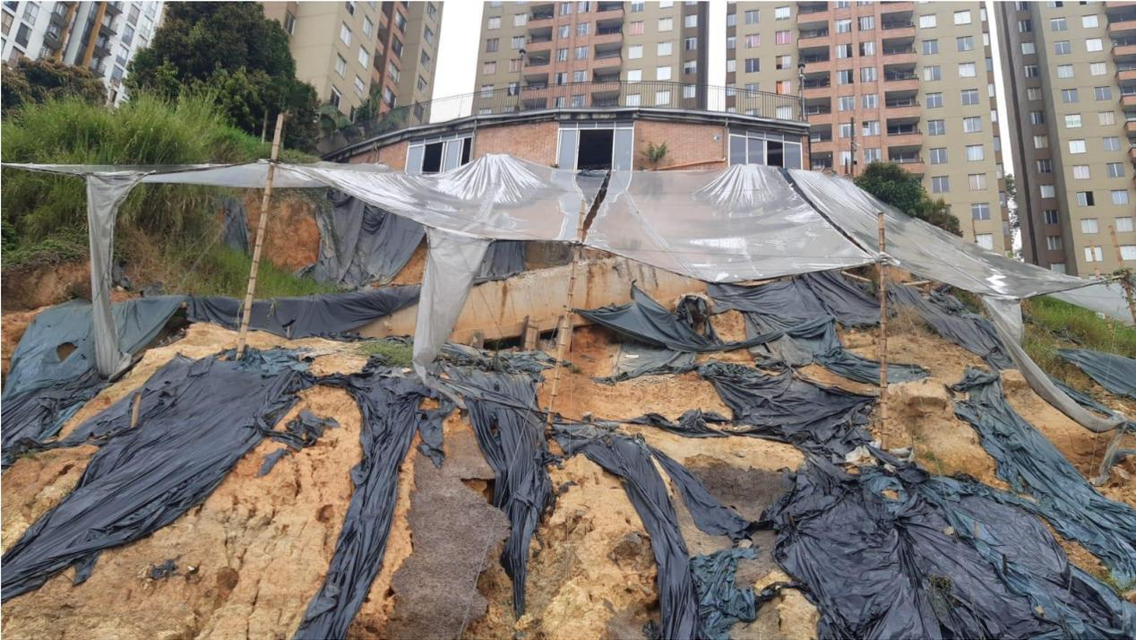
FOTOGRAFIAS A JUNIO DE 2023 – CRATERES PROVOCADOS POR EL AGUA PROVOCANDO INESTABILIDAD. AMENAZA DE NUEVO DERRUMBE DE LAS ESTRUCTURA DE CONSTRUCCION SUPERIOR
